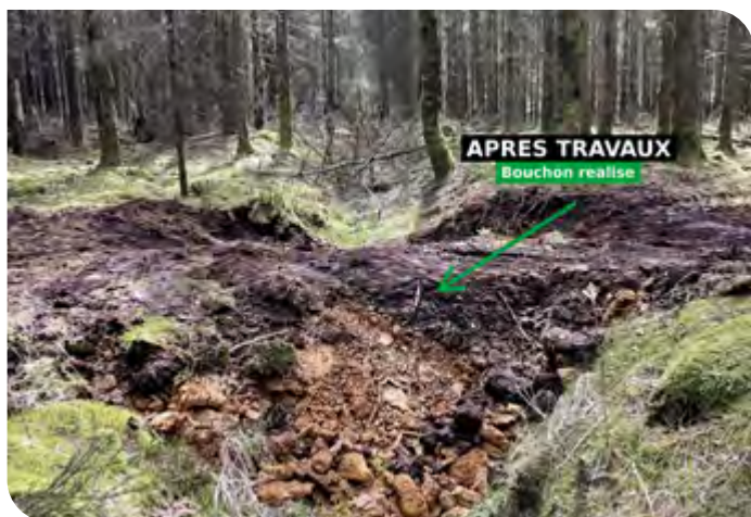
Bouchage d'un drain forestier au Bois Mousseux Est., Spa (Source Parc Naturel des Sources)
