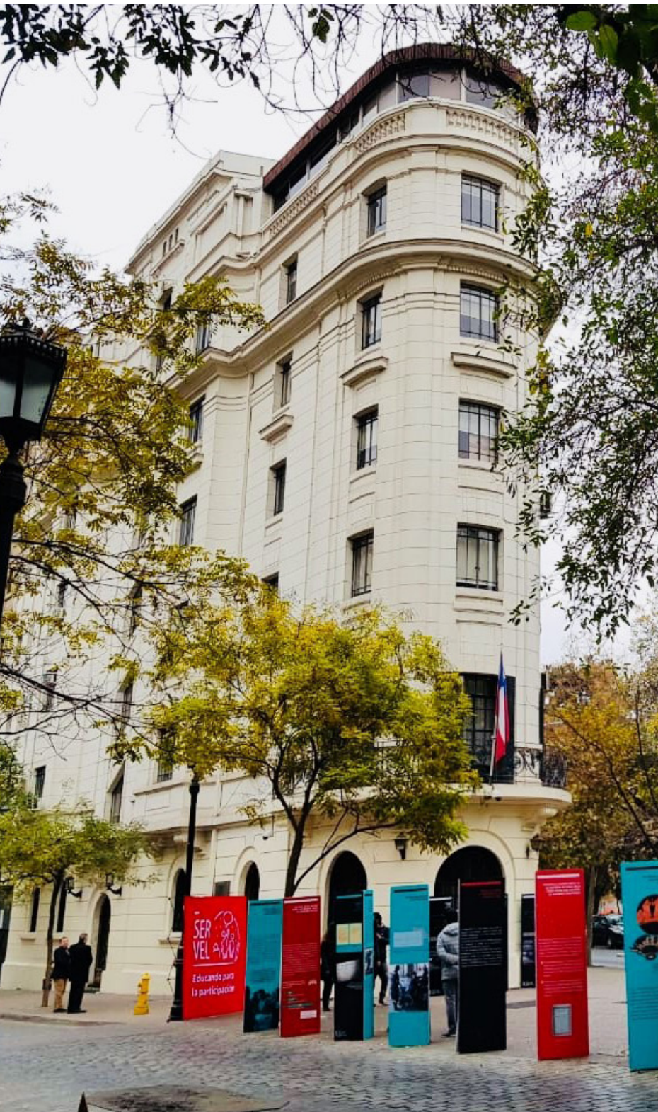
Edificio Institucional de Servel que en 2019 por primera vez fue abierto al público en el Día del Patrimonio Cultural.
