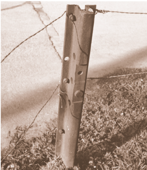
Die englische Brückenschiene von Benken SG, deren einstige Weiterverwendung als Schwellenverstärkung noch leicht erkennbar ist. (Foto A. Heer)
