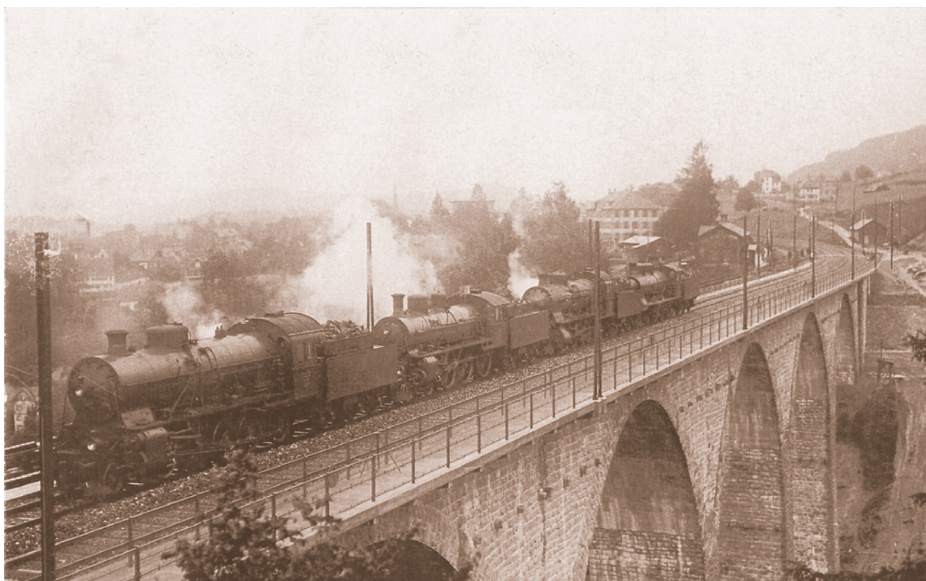
Im Frühjahr 1926 erfolgte die Belastungsprobe der neuen Sitter-Brücke der SBB. (Sammlung K.Anderegg)
