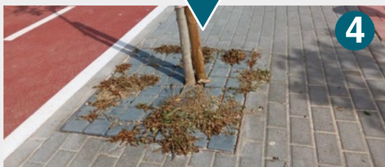
Foto 3: Estado del alcorque antes del tratamiento.
