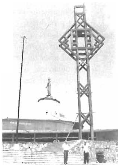
Torre para la colocación de las campanas. Caacupé
